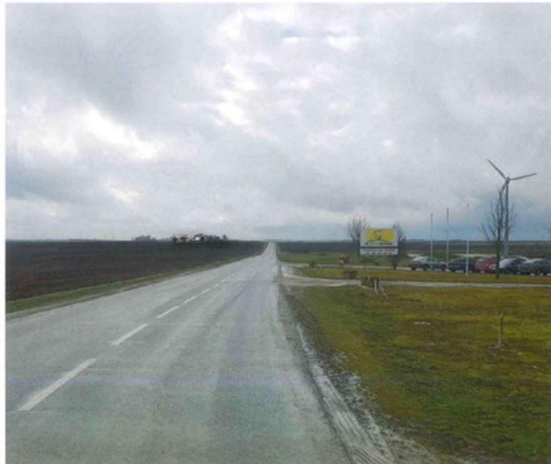
Figure 14 : Vue depuis le Nord
